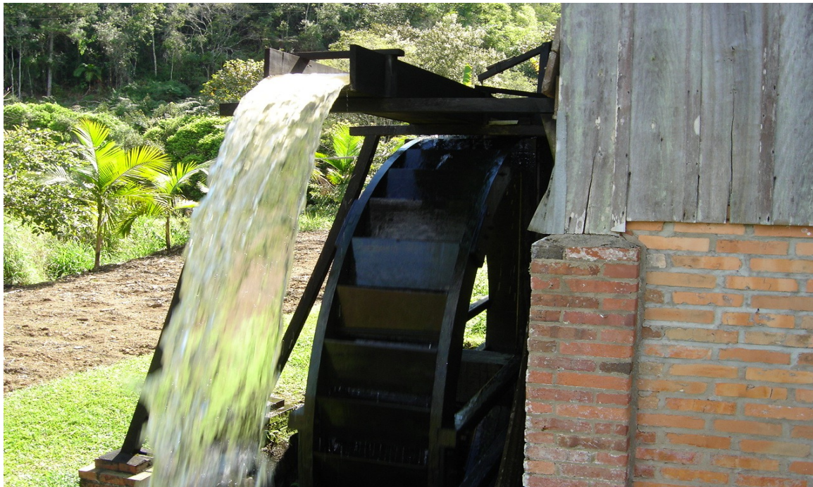
FOTO DA RODA D'ÁGUA, JUNTAMENTO COM A ESTRUTURA DA EDIFICAÇÃO
